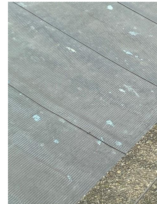
Detailopname van de dakbedekking op één van de langsvleugels, vermoedelijk Sopralast 50 TV Cuivre.
